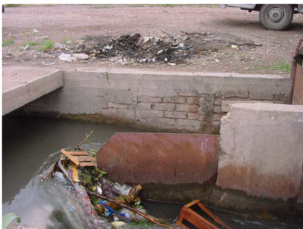
Foto 3: Hijuela Guevara: material acumulado en la hoja partidora (rotonda de Regalado Olgún y Boulogne Sur Mer , costado Norte)
