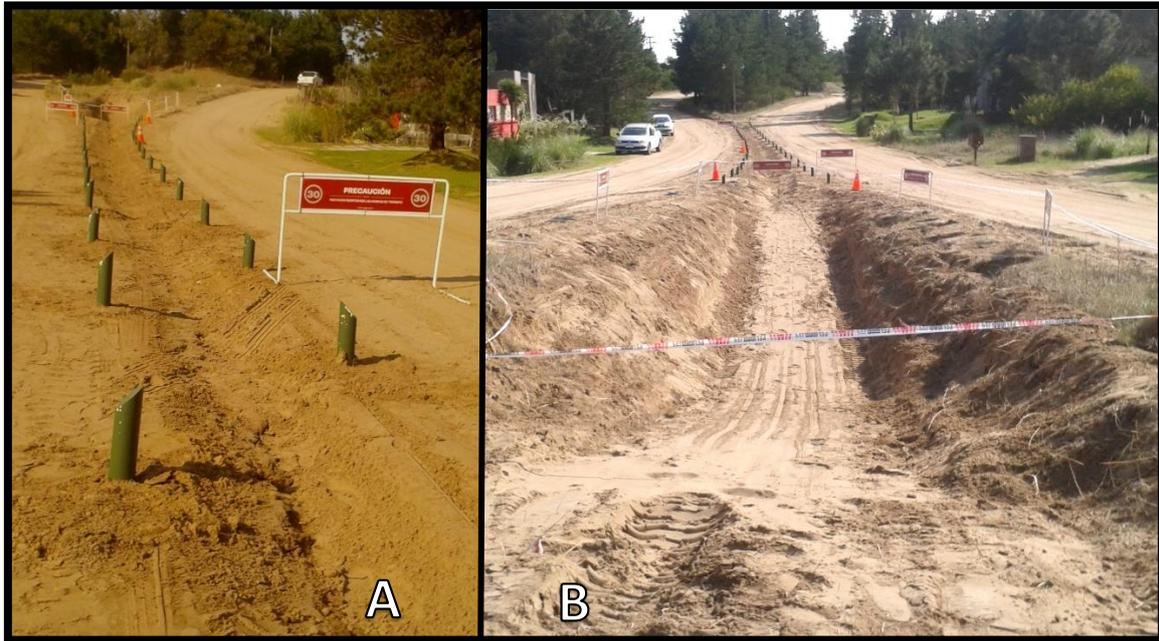
Fig. 9 A-Badén a cielo abierto, B-Dren construido
