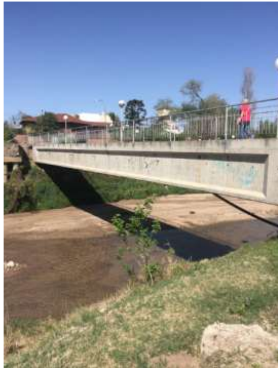
Figura V.2. Fotografía de la pasarela próximo a la calle José Estrada.
