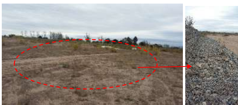
Figura VIII.15. Gaviones y colchonetas en el sector 2.
