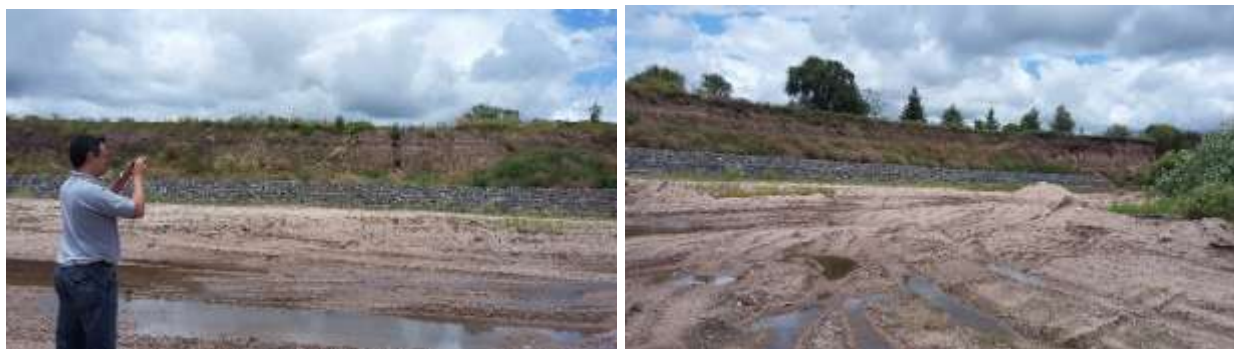
Figura VIII.14. Gaviones en el sector 1.
