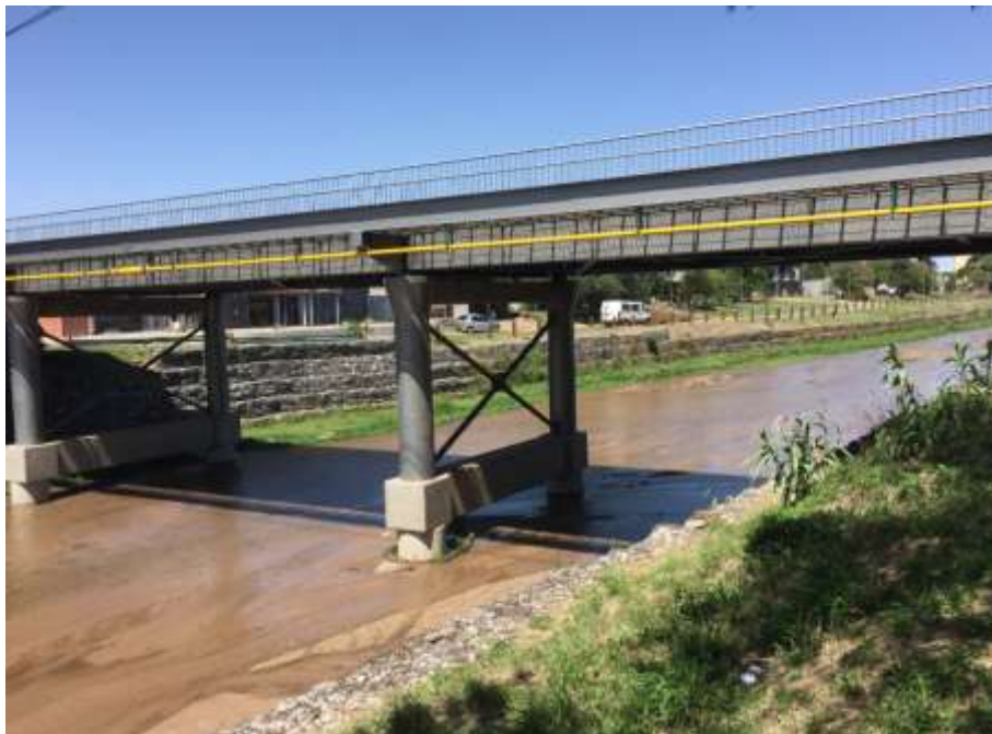
Figura V.3. Fotografía del puente de la calle Cleto Peña, ubicación de los gaviones.
