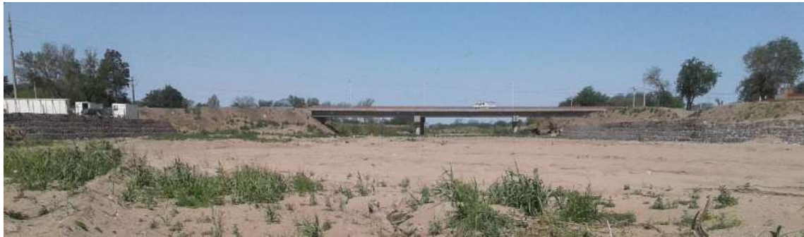
Figura V.4. Fotografía del puente de la Ruta Nacional 9.
