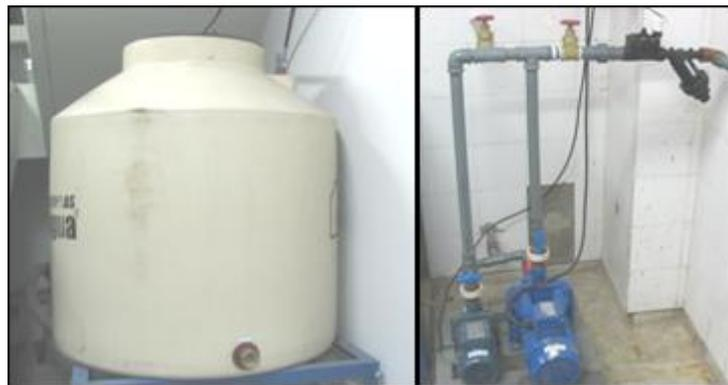
**Figura 8.- Fotografía del tanque de alimentación y bombas de presurización del sistema**
